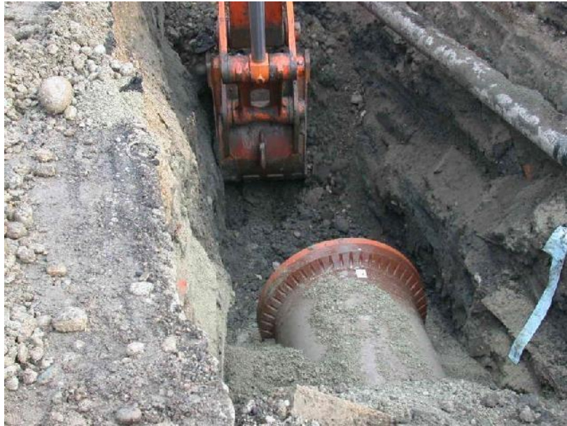
Costruzione di un collettore consortile a Zibido San Giacomo (Mi)
