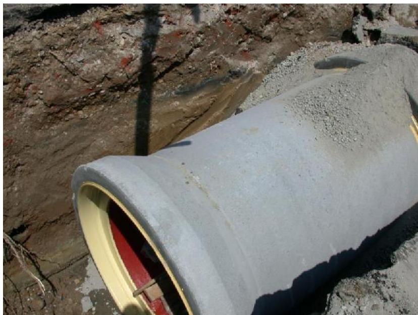
Ricostruzione di un collettore comunale in via Torino a Rozzano (Mi)
